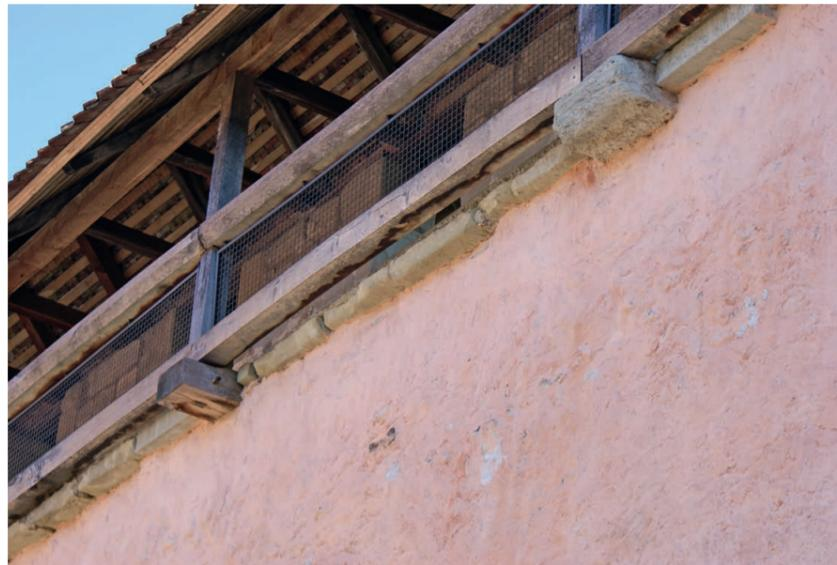
1994 wurde auf das Bollen- und Bruchsteinmauerwerk hinter der Deutschen Kirche eine Oberflächenschlämme aus Sumpfkalk, feinem Sand und farbigen anorganischen Erden aufgetragen. Diese ist nach 17 Jahren noch intakt, hat sich aber zunehmend verfärbt und erscheint heute in seinem Rotton etwas unnatürlich. Auf dem Bild ist je eine Konsole aus Muschelkalkstein und Eichenholz ersichtlich, diese tragen die Ständerkonstruktion des Wehgangdaches.
