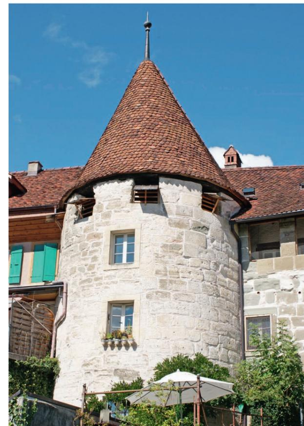
A la fin des travaux de restauration de 1997, la Tour sans nom aux murs badigeonnés à la chaux paraissait trop claire et blanche par rapport à l'ensemble. Quinze ans après, sa teinte a viré à l'ocre et le dessin des joints de la maçonnerie en pierres de taille est redevenu visible, de sorte que la tour est à nouveau totalement intégrée dans la fortification.
