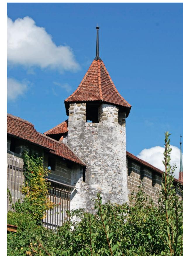
Das Bruchsteinmauerwerk des Kleinen Schimmelturms, 1999 mit einer Kalkschlämme überzogen, weist auf der Wetterseite grössere graue Flecken auf, erscheint auf der Ostseite nach zwölf Jahren jedoch immer noch in hellem Kalkweiss.
