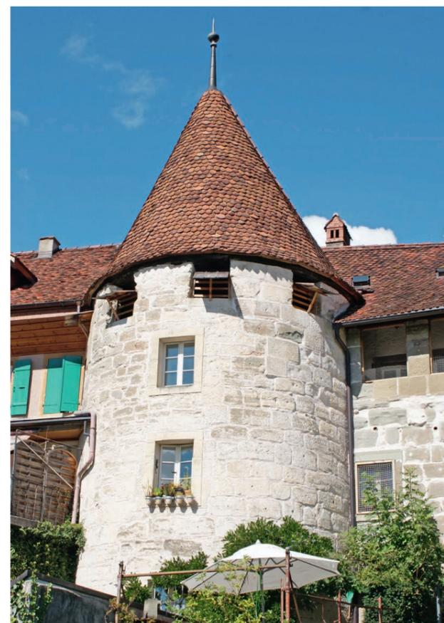
Der namenlose Turm wirkte durch die angebrachte Kalkschlämme unmittelbar nach der Restaurierung 1997 in hellem Kalkweiss fast als Fremdkörper. Nach fünfzehn Jahren erscheint er gefleckt in braunem Ocker und das Fugenbild des Quadermauerwerks ist teilweise wieder sichtbar, womit sich der Turm von neuem ins Gesamtbild der Ringmauern integriert hat.
