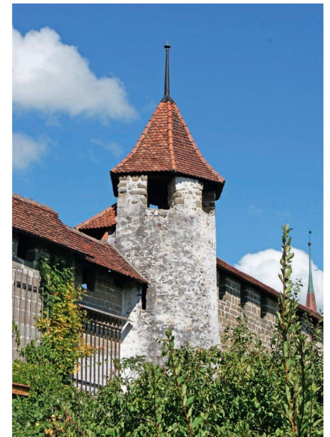
Sur la maçonnerie en pierres de carrière du Kleinen Schimmelturm, recouverte d'un badigeon de chaux en 1999, des taches grises sont apparues sur le côté exposé aux intempéries, tandis que le côté est a gardé tout au long de ces douze années sa belle couleur blanc calcaire.
