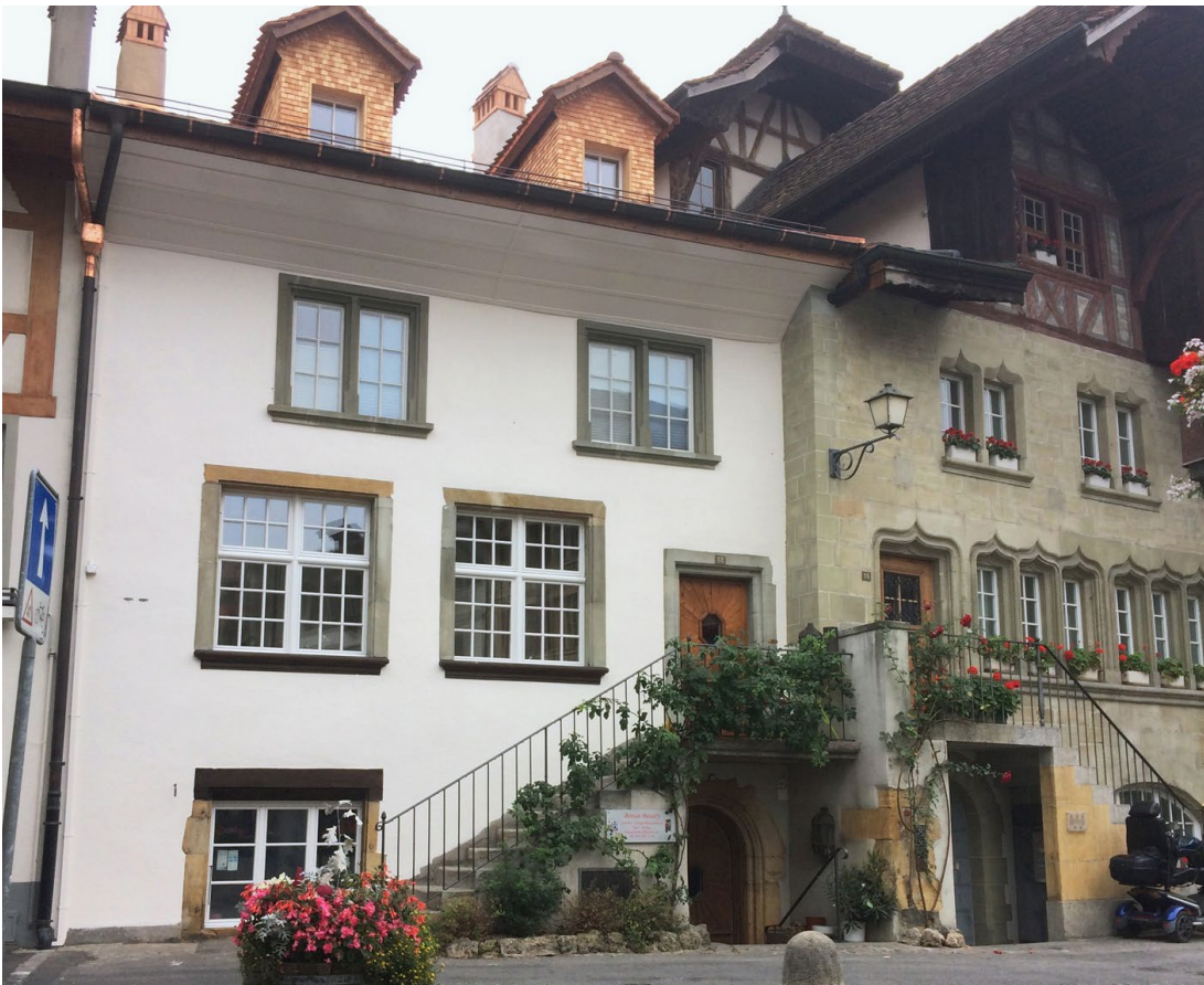
Nach der Sanierung. Après la rénovation.
