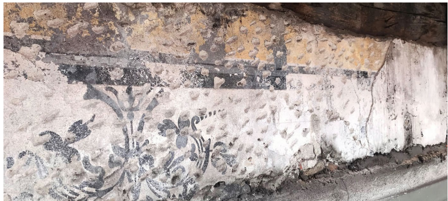
Alte Fassadenmalerei im Bereich des Vordaches mit Dekorationsmalerei.
