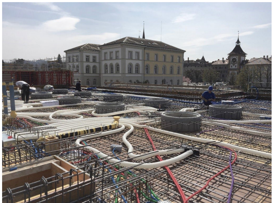
Blick in die Innereien der Betondecke des Mittelteils – und Ausblick auf Berntor und Berntorschulhaus. (Bild: LZ&A Architekten AG)
