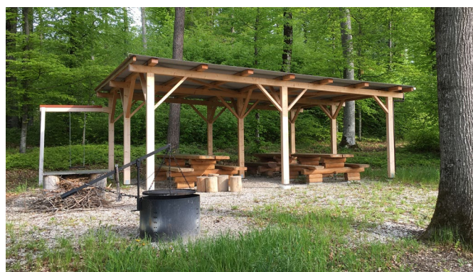
Grillstelle / place de grillade Dählholz Lurtigen
