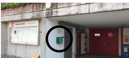
Bei der Zivilschutzanlage in Courlevon, Dorfstrasse 17a
