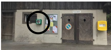
Au four à pain à Hauteville Altavilla-Strasse 52a
