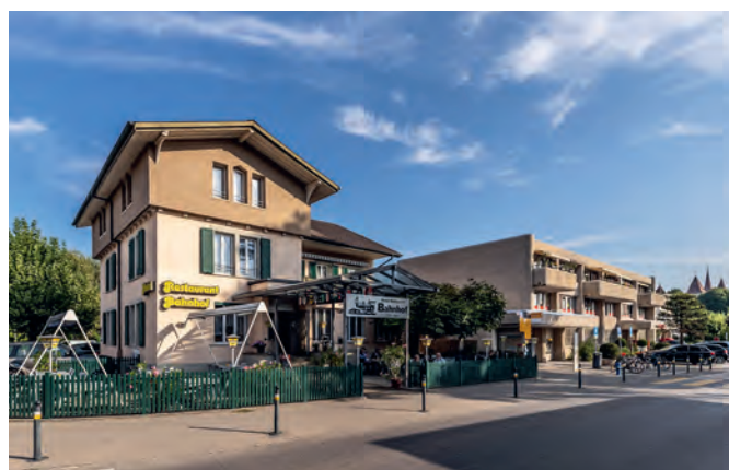
Fernwärmeanschluss Hotel-Restaurant Bahnhof, Murten
